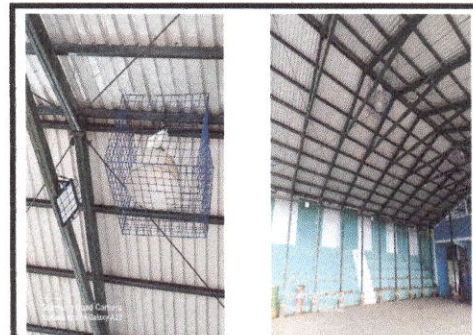
Foto 6: mejoramiento de red eléctrica.
