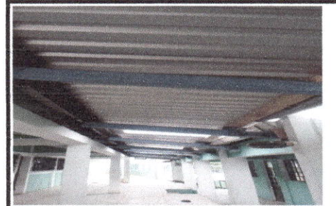
Foto 4: Sustitución de cubierta de lámina.
