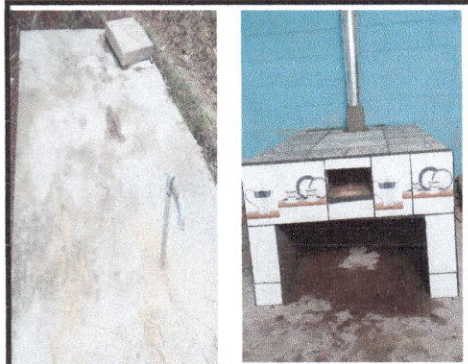
Foto1: Sustitución de red de drenaje y mejoramiento de cocina escolar.
